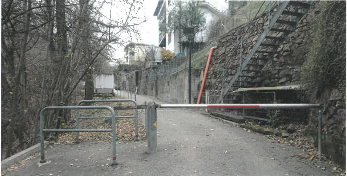
Figura 12 - Barriera che impedisce il passaggio in bicicletta
