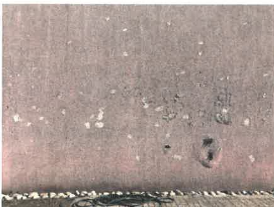
Fotografia della facciata sud allo stato attuale.
