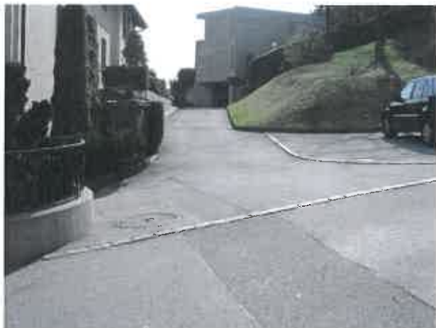
Punto iniziale dell'intervento su Via S. Rocco
