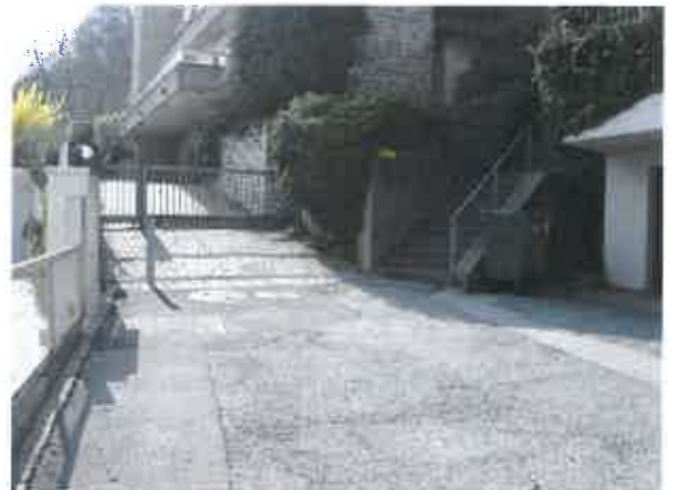
Punto iniziale dell'intervento sul tornante della Via ai Ronchi
